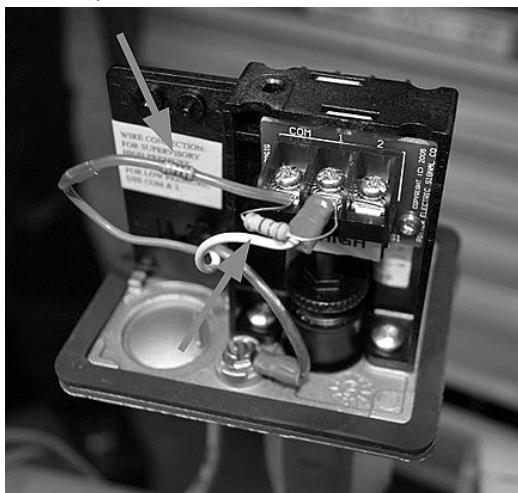
Рис. 7 Пример установки сопротивлений (резисторов) в корпусе реле давления
